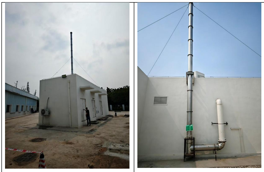
图 4 污水处理站站房及废气排气筒
