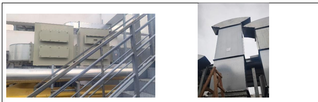
图 7 实验废气净化装置及排气筒
