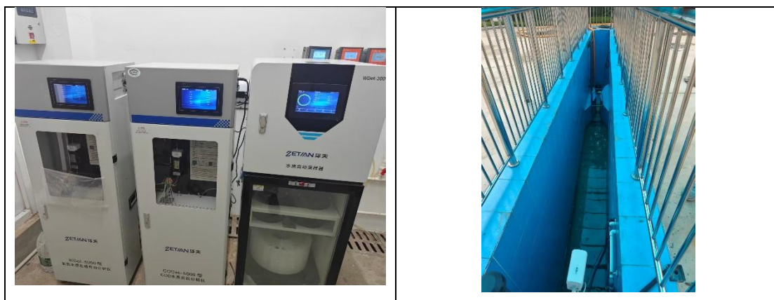
图 9 在线监控设备及流量槽
